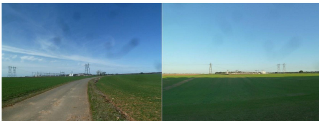
Photo 3 : Le poste de ROM vu de la route d'accès en direction ouest.
