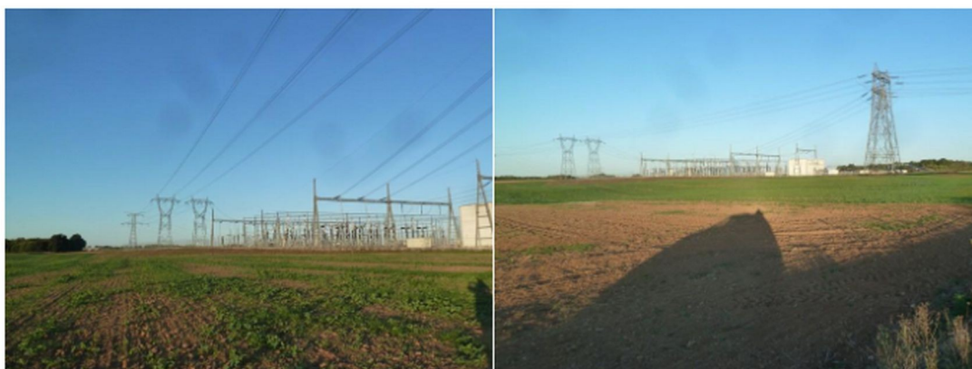
Photo 1 : Emplacement retenu pour l'extension du poste à l'est du poste existant de ROM. Prise de vue en direction sud-ouest.
