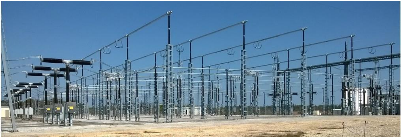
Figure 9 : Jeux de barres 400 kV existant à prolonger
