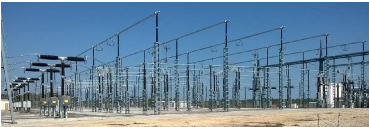
Figure 6 : Jeux de barres 400 kV existant à prolonger
