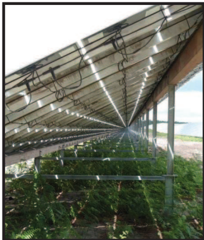
Photo 35 : Rais de lumière filtrant à travers les interstices de 2 cm disposés entre les modules Source : EDF EN France – Centrale photovoltaïque de Narbonne
