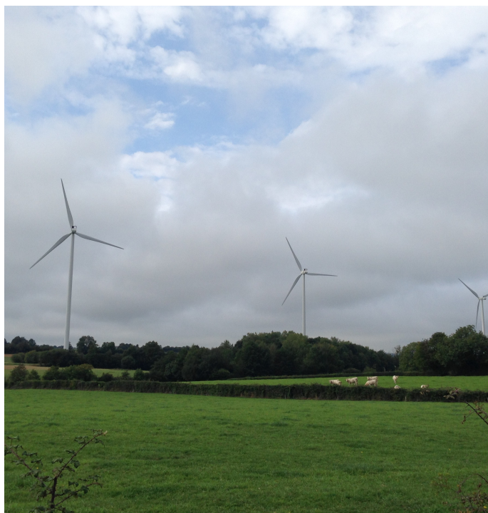
« Energies Eolienne » – Vernoux en Gâtine – DT79, 2015
